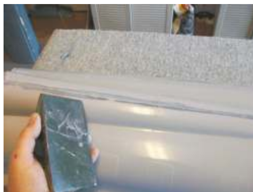
Roughen contact surfaces Aufrauen der Kontaktflächen
